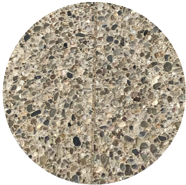
Formigó desactivat amb àrdi vist
